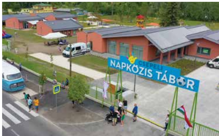
A Csepeli Napközi Tábor 13 500 m 2 -es területen, 500 m 2 -es főépületével és több kisebb melléképületével szintén a HORIZONT™ acélváz as technológiával épült.
