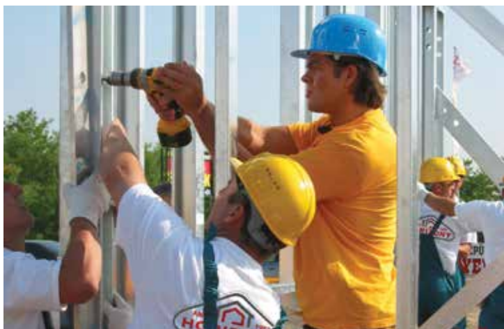
Egy 160 m 2 -es ház esetén a szerkezetállítást 16 munkaóra alatt végzi el egy hétfős csapat a helyszínen.
