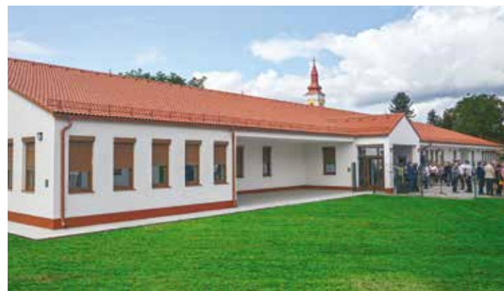
Az elkészült óvoda és bölcsőde épülete Gerjenben
