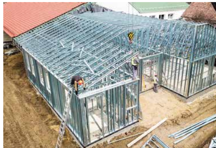
Sportközpontú óvoda és bölcsőde építése a Tolna megyei Gerjen községben.
