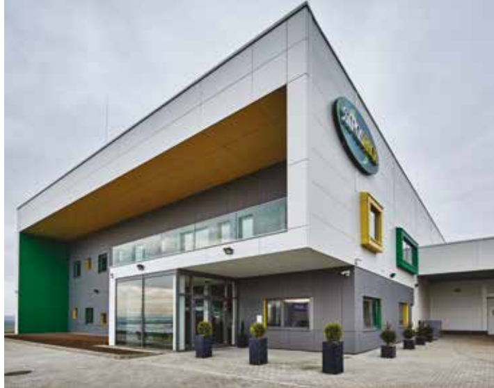
Sipospack Reklám- és Csomagolóanyag Gyártó Kft. üzemcsarnoka, Sósikút
