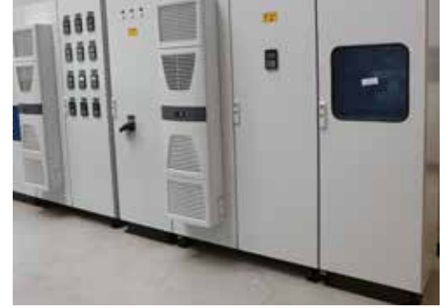
Rittal gyártmányú villamos elosztó- és vezérlőszekrény
