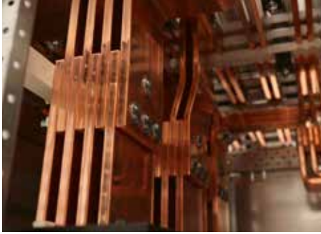
Erősáramú villamos elosztószekrény áramvezető rézsíne-zése, a sínek gyártása CNC vezérlésű gépekkel történik
