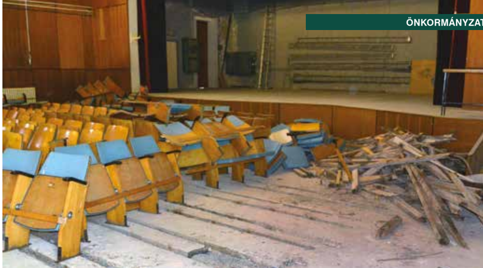
Megkezdődött a sárbogárdi művelődési központ közösségi célú felújítása
