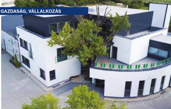
A VESZ-MONT 2000 Kft. tavaly átadott, új központja Nemesvámoson
