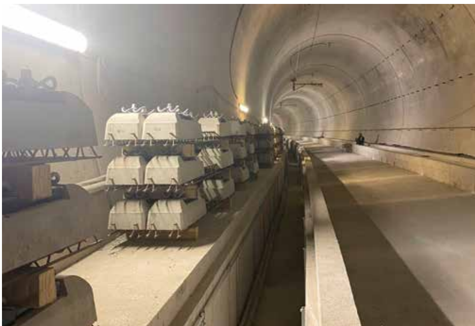
Épül az új, a koperi kikötőig futó szlovén gyorsvasút. Az első alagút már el is készült
