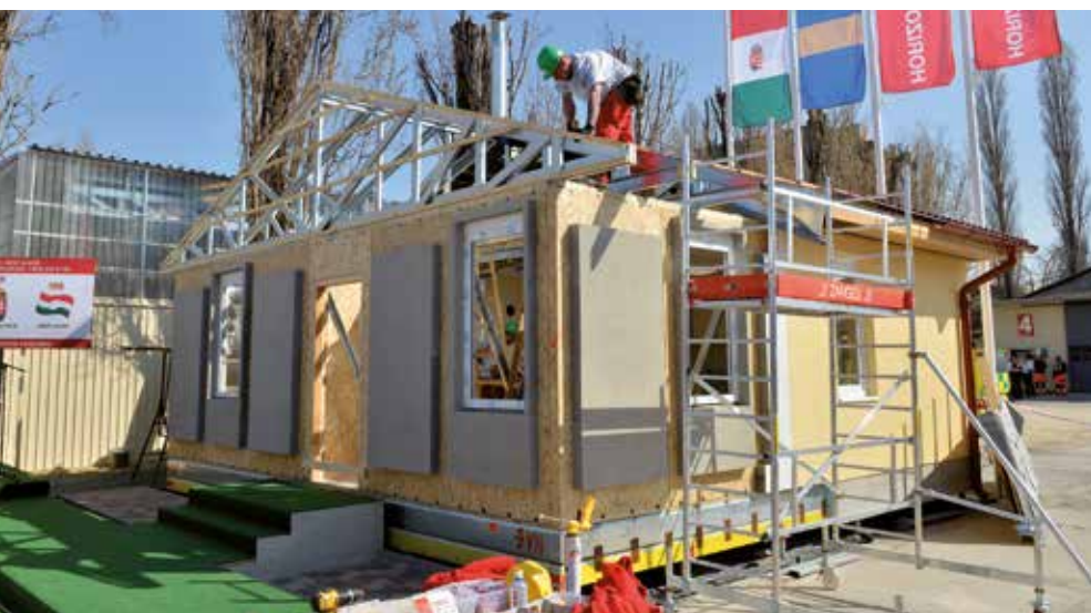
A Fészekház prototípusának befejező munkálatai
