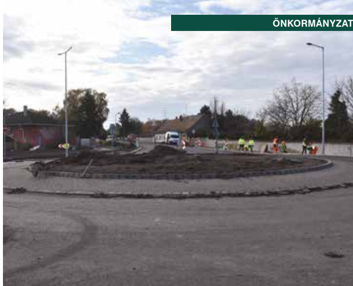
Folytatódnak az út- és járdafelújítások
