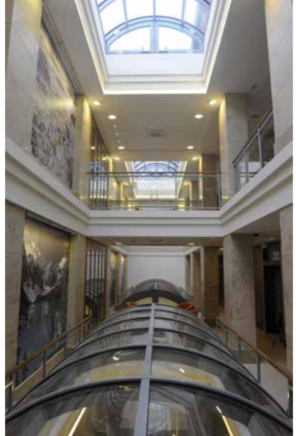
Fehérvár Travel Irodaházának építése, belső enteriőr
