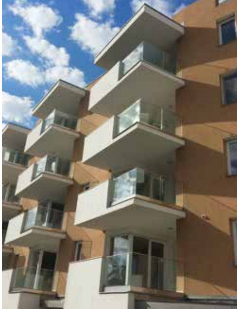
Siófok Aranypart Szolár Villa II. ütem műszaki ellenőrzése, műszaki bonyolítása
