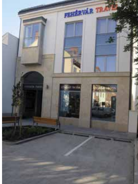
Fehérvár Travel Irodaházának építése konzorciumban, generál kivitelezéssel
