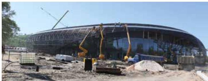
Végéhez közelednek a tatabányai sportcsarnok munkálatai
