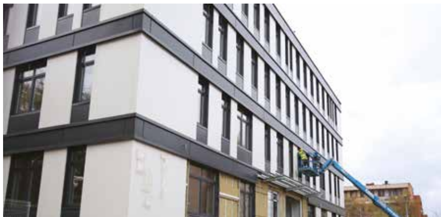
A Járási Hivatal új épületének munkálatai
