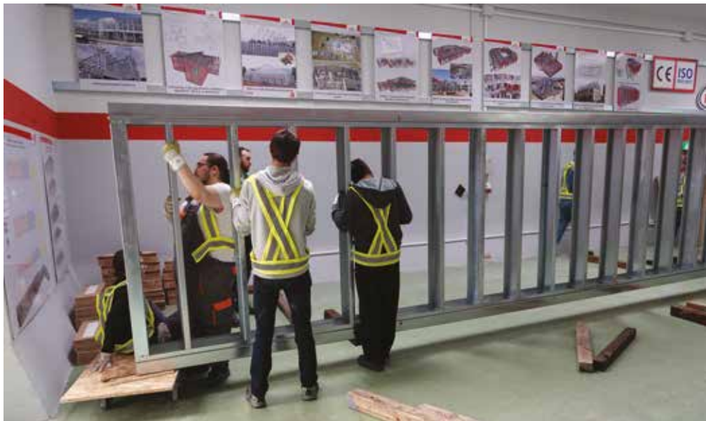
Munka közben: így készült a Koeb csapat versenyháza, telephelyünkön
